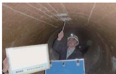
管頂部における測定状況
