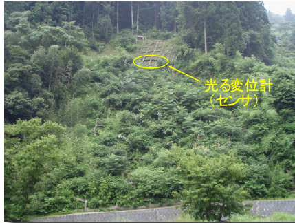
植生が成長した法枠の遠望目視
