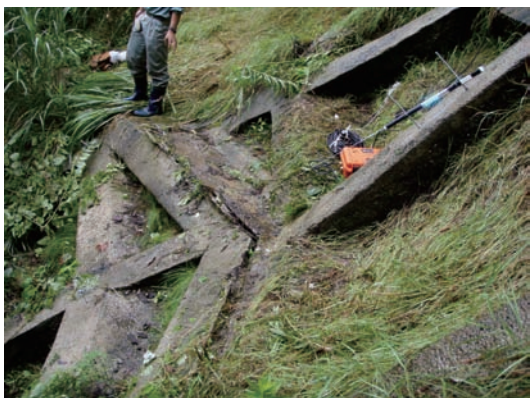
光る変位計設置
