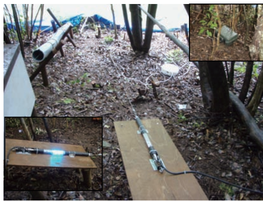
光る変位計設置
