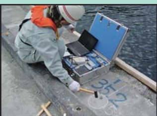
鋼矢板の根長調査例
