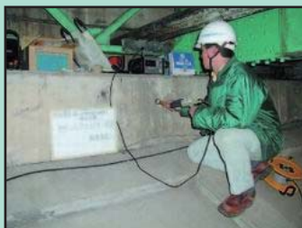
手動打撃による橋梁点検例
