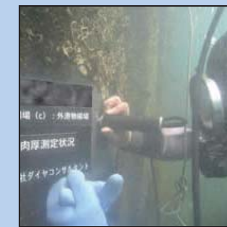
鋼矢板肉厚測定状況 (水中作業)
