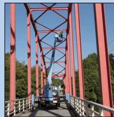
高所作業車による橋梁点検例
