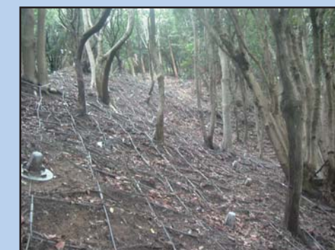
ロープネット・ロックボルト併用工法施工例
