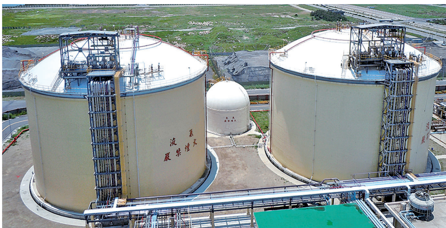
液体アンモニアタンクの外観(石井鉄工所提供)
